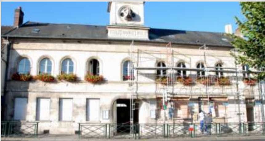
La mise en place de l'échafaudage sur la façade
