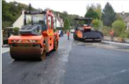
Compacteur et finisseur en action à la Raizière
